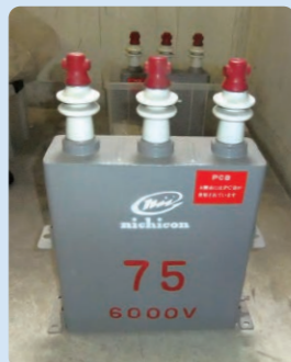
電力用コンデンサー
